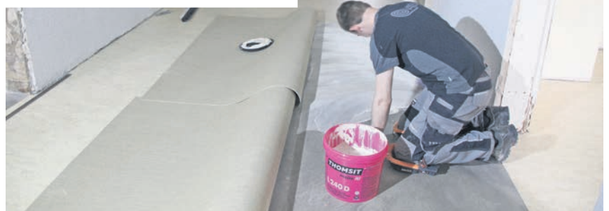
Die Innenarbeiten laufen auf Hochtouren.
